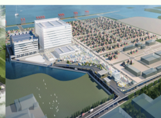
宁波-舟山港三期集装箱码头配套 停车场项目二期
