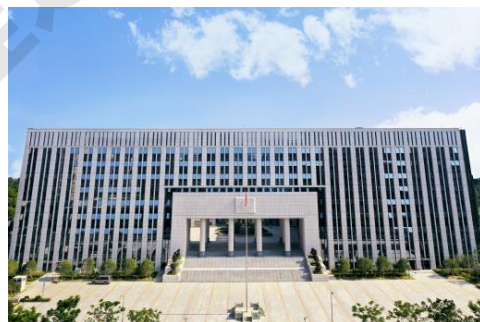
宁波市公安局业务技术用房迁建项目
