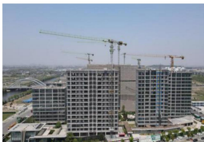
在建项目天润建筑慈白沙 I202004#地块
