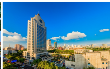
宁波检验检疫大楼(鲁班奖)
