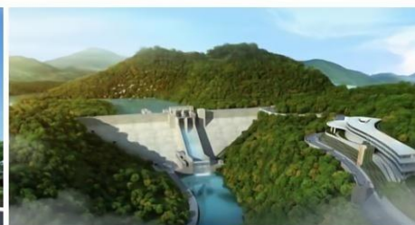
奉化柏坑水库
