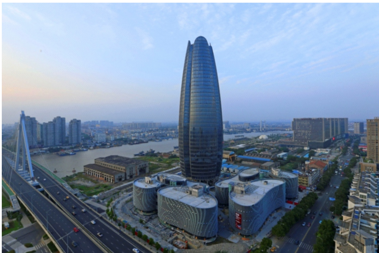
宁波财富中心（采用高强高流态混凝土）
