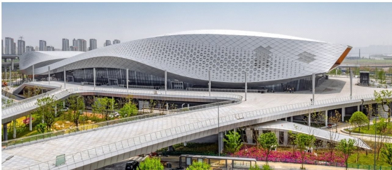
宁波奥体中心项目（游泳馆）应用陶粒混凝土产品
