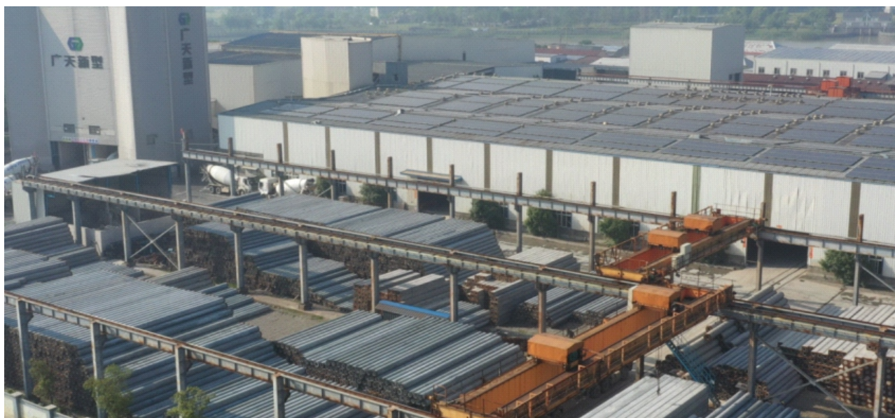
广天构件管桩堆场
